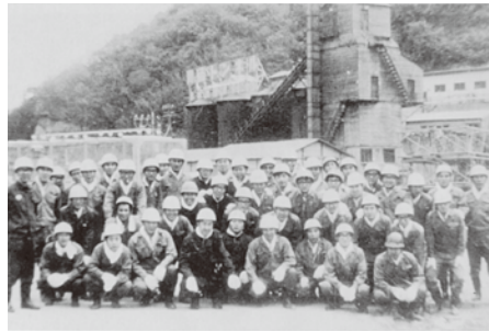
●1968年 青函トンネル工事調査
